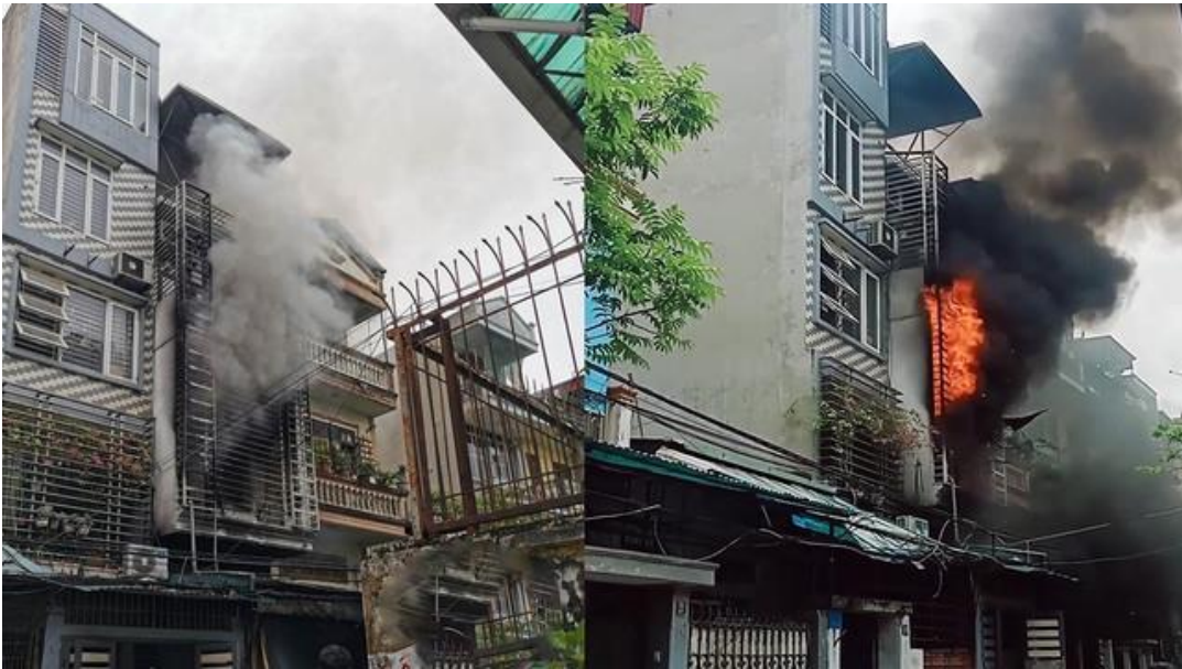
Hiện trường vụ cháy tại phường Quang Trung, quận Hà Đông, Hà Nội
